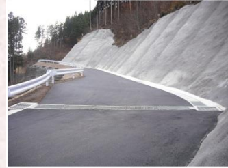
完成写真 (越波谷第3砂防堰堤管理用道路)
