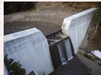
完成写真(上葛谷砂防堰堤)
