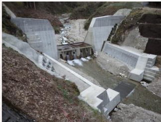
完成写真(地谷第2砂防堰堤)
