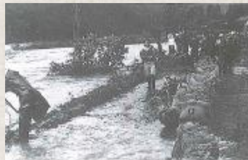
← 「川原地区」 河川氾濫の 応急工事
