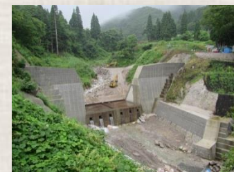
地谷第2砂防堰堤
