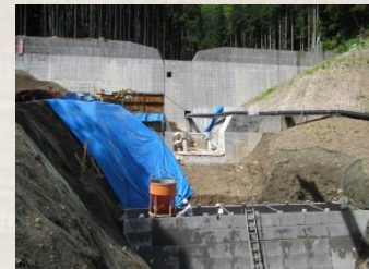
コンクリート打設(床固工)
