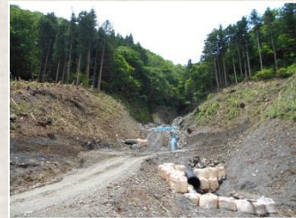
工事に着手した下河原谷
