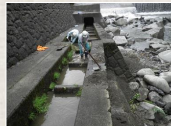
魚道に堆積した土砂の撤去
