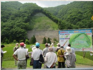
八草川山腹工事現場の見学
