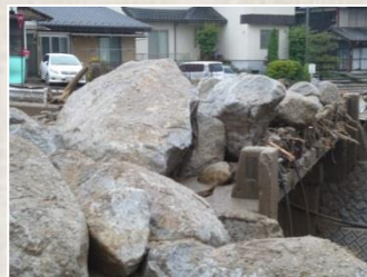
長野県南木曾町での土石流で多数の巨大な岩が橋梁に
