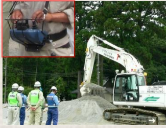
分解型遠隔操作式重機の操作 (左上:操作時の拡大写真)
