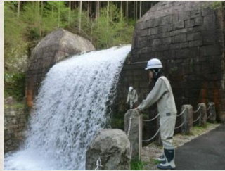
鷲津谷第1砂防堰堤での点検
