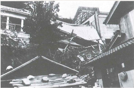
徳山小学校崩壊
