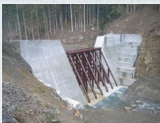
大蔵谷第1砂防堰堤
