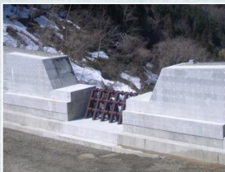
寒谷第1砂防堰堤
