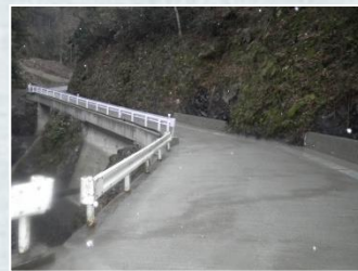
拡幅された林道
