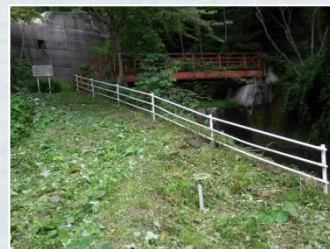
転落防止柵の補修 （ドン谷第1砂防堰堤）
