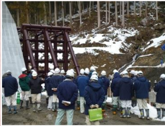
鋼製透過型砂防堰堤の 施工状況を見学
