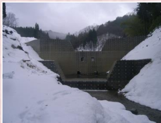
竣工した大仲津谷第1砂防堰堤
