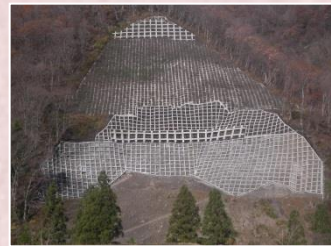
復旧が進む八草川山腹工
