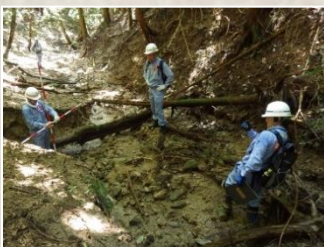
広島市土砂災害の溪流点検
