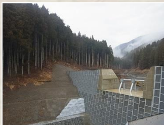
敷原谷第1砂防堰堤
