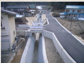
ドン谷溪流保全工
