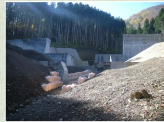
今年度の工事が完了した 大河原岡谷第1砂防堰堤
