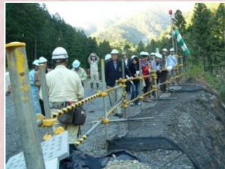
大蔵谷第1砂防堰堤工事の見学
