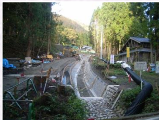
紅葉のなか 護岸工を施工
