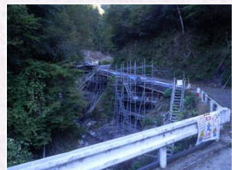
施工中の張出床版工
