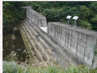
寒谷第1砂防堰堤
