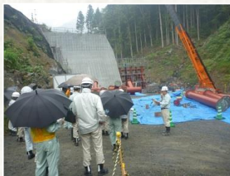
工事内容の説明
