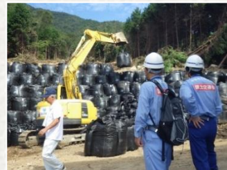
応急復旧が進んでいます
