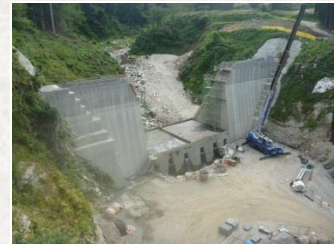
本堰堤の施工状況
