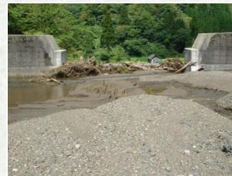
土砂・流木捕捉後 (鋼製流木止めが隠れています)
