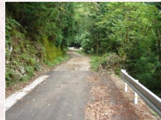
施工箇所（手前は拡幅済み）
