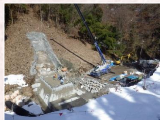
積雪の残るなか Co打設
