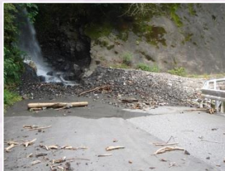
林道内谷線への 土砂流出状況
