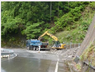
県道神原西津汲線での 土砂撤去状況
