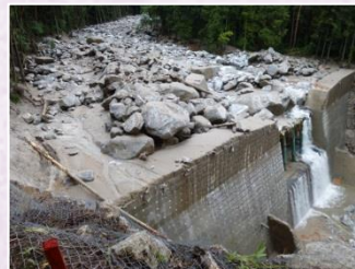
土石流の一部を捕捉した 梨子沢第2砂防堰堤
