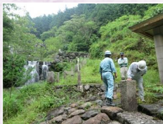
下辻谷第2砂防堰堤の点検
