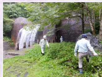
鷲津谷第1砂防堰堤の点検
