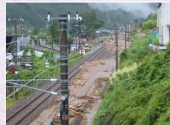
JR中央本線の被害状況
