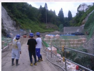
工事現場の見学 (地谷第2砂防堰堤工事)
