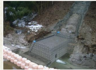
昨年度の工事完了状況
