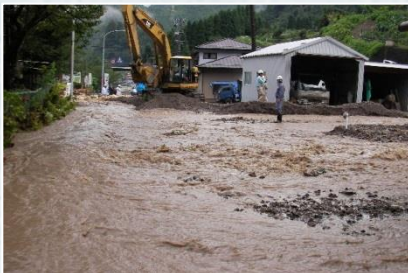
下谷で発生した土砂災害 (H20.9)
