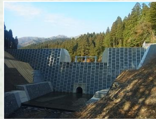
敷原谷第1砂防堰堤
