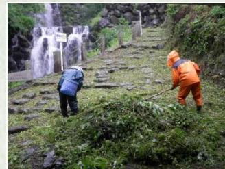
利用施設の除草作業(昨年)
