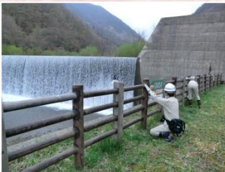
施設点検の様子
