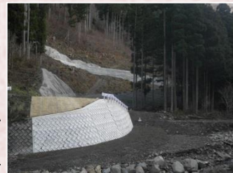
昨年度の工事完了状況
