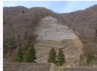
昨年度の工事完了状況
