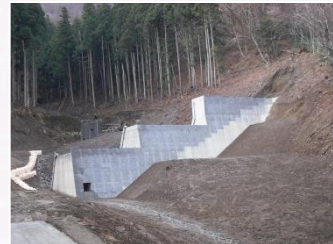
昨年度の工事完了状況
