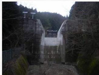
小砂谷第1砂防堰堤
