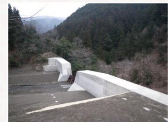
大井谷第1砂防堰堤
