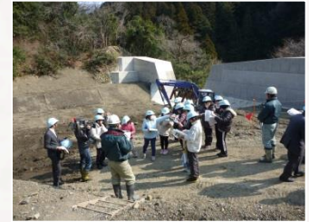
大井谷において砂防工事の現場を見学
