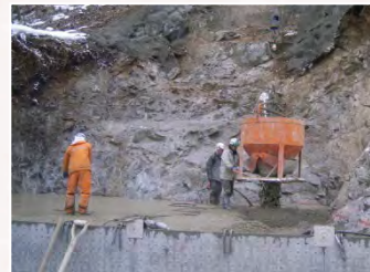
寒風の中 コンクリート打設
