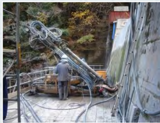
ボーリングマシンによる削孔状況
