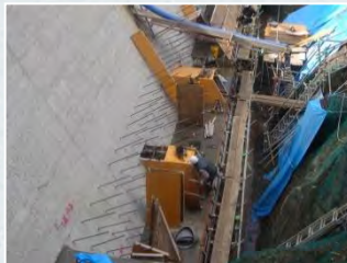
挿筋後の型枠組立状況
