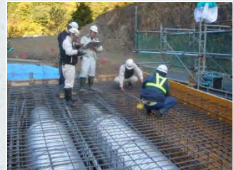
鉄筋組立完了後の段階確認検査実施状況
