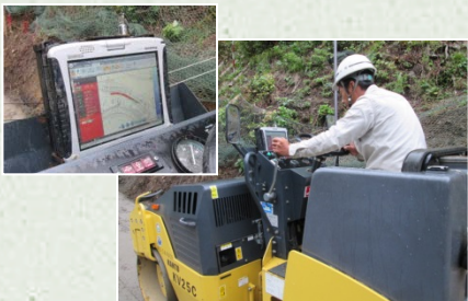
画面を確認しながら中詰材の締固め
