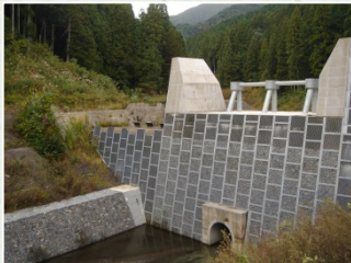
敷原谷第1砂防堰堤
