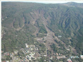
伊豆大島の被災状況
