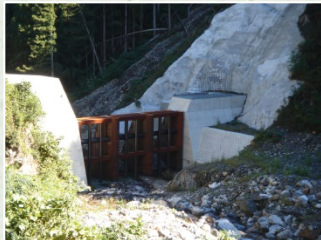
外津汲内容第1砂防堰堤
