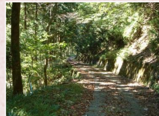
林道拡幅箇所
