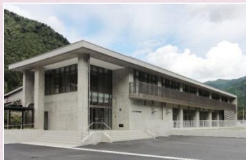
完成した東館
