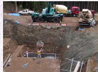
大河原岡谷第1砂防堰堤
