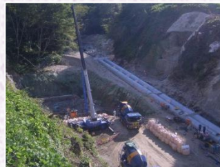
地谷第2砂防堰堤
