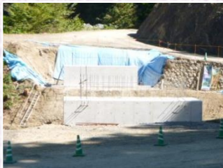
橋梁上部工の工程へ
