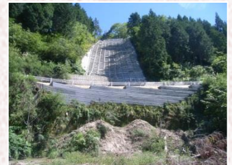
本復旧が完了
