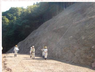
法面の地質判定
