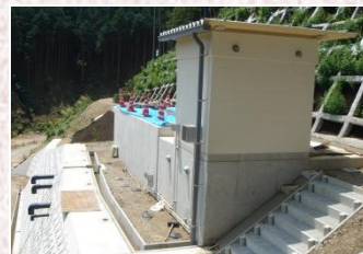
調整運転中の水道施設
