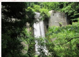
上葛谷砂防堰堤
