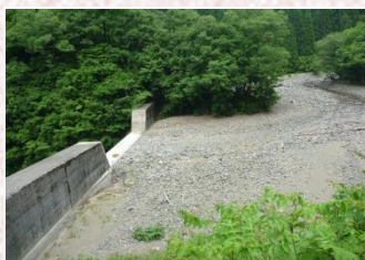
矢中谷第2砂防堰堤
