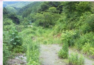
橋梁設置位置 (高地谷左支溪天狗谷)
