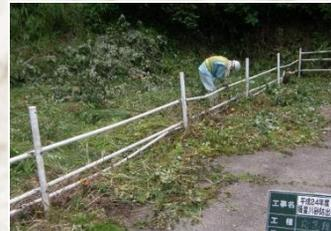
積雪により破損した安全柵の修繕状況（昨年度）
