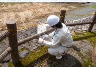
防護柵の破損表示 (ナンノ谷第2砂防堰堤)
