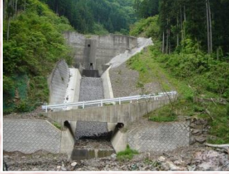
堆砂した越波谷第3砂防堰堤
