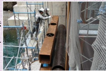
鋼製堰堤組立作業の様子
