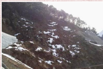
雪解けが進んだ施工箇所
