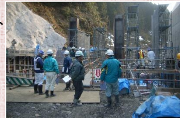
内谷の現場を点検する参加者
