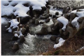
一部流出したブロック
