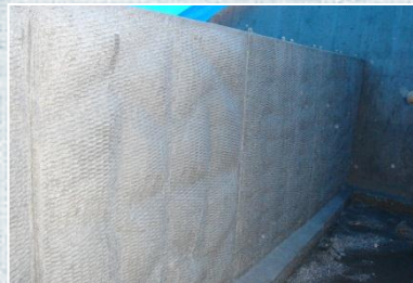
手前が化粧タイプ、奥が化粧なしタイプの型枠の仕上がり状況
