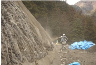
モルタル吹付工の施工状況
