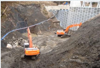
前庭保護部の掘削状況
