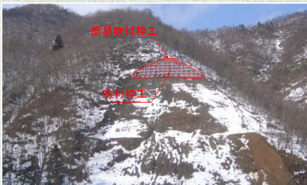
施工完了箇所 (H24.12末現在)
