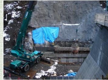
コンクリート打設状況
