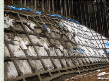
法枠工の施工状況
