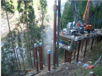
メタルロードの施工状況 写真提供: 多治見砂防国道事務所
