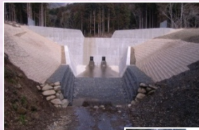
日洞第1砂防堰堤
