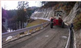
舗装終了で工事完成へ
