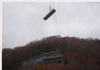
高所での作業のため 資材は索道で運搬
