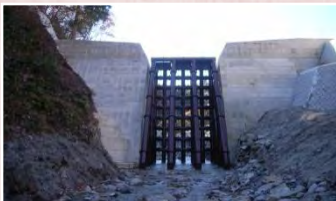
完成した砂防堰堤
