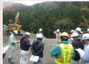
大蔵谷第1砂防堰堤道路工事
