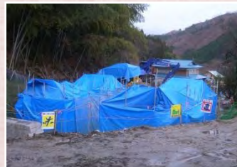
コンクリート養生中
