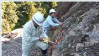
大蔵谷第1砂防堰堤道路工事にて岩質の確認(奥)
