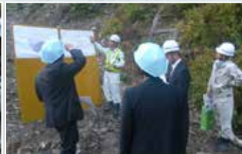
山腹工事の進捗状況説明
