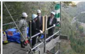
崩壊地上部より崩壊箇所や 周辺の状況を確認
