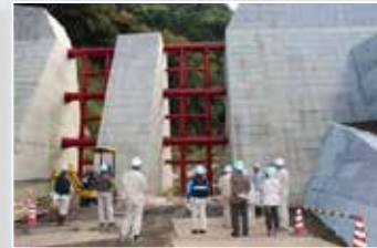
宇津志谷第1砂防堰堤の工事現場見学
