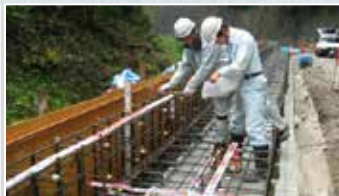
瀬戸谷第1砂防堰堤工事にて鉄筋組立状況確認(手前)
