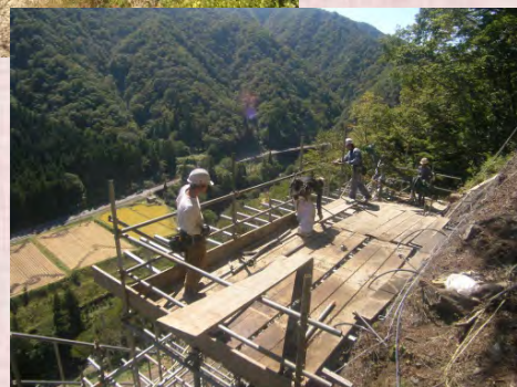
安全な作業を行うための足場を設置するのにも一苦労
