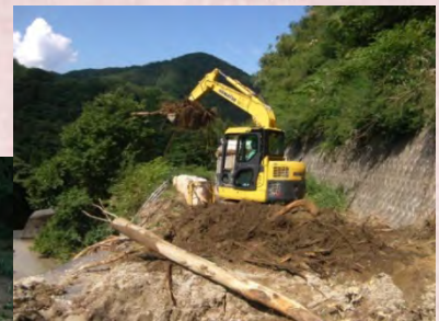
貝月谷管理用道路に堆積した崩壊土砂を撤去
