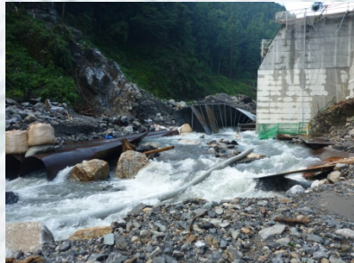
外津汲内谷第1砂防堰堤
