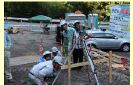
設置した丁張の精度を確認
