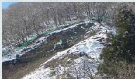
H22 応急復旧工事の様子
