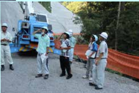
大蔵谷では断層破碎帯の法面対策を見学 (施工：(株)久保田工務店)
