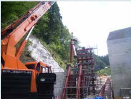
鋼製堰堤の組み立て状況
