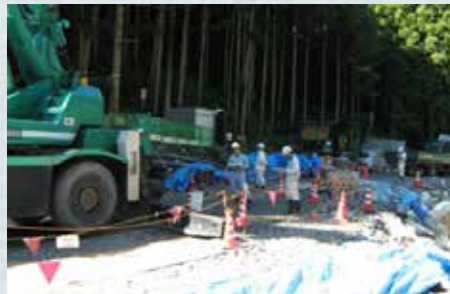
外津汲内谷の工事現場点検
