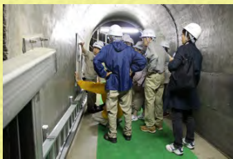
横山ダムの監査路
