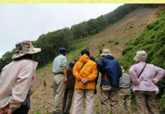
坂内川上地先の山腹崩壊
