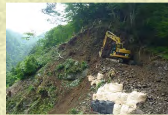
急峻な法面の切土
