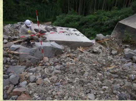
平成23年8月25日の豪雨により土石流を捕捉した越波第3砂防堰堤(本巢市根尾越波)の緊急調査
