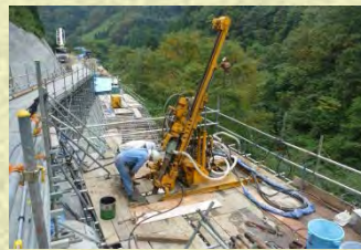
施工足場を工夫
