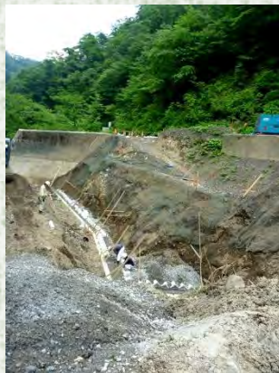
西前の谷は ブロック積工に着手
