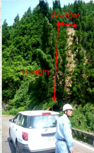
東津汲で発生した表層崩壊
