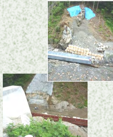
内谷(上)と瀬戸谷(下)では樋工(仮排水路)を施工中
