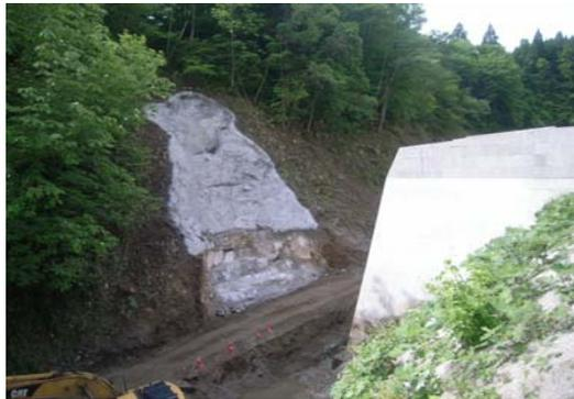
堰堤の床掘作業中です。右側手前は左岸側のコンクリート堰堤。
