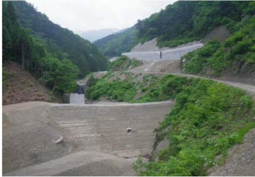
H24.5.28に本堰堤施工のための仮締切堤が完成!
