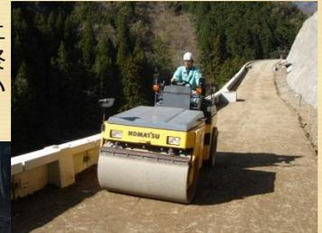
宇津志谷では、堰堤の上流部を施工するための工事用道路を作っています
